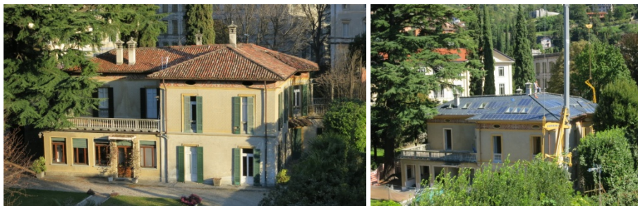
Figura 1 - L'edificio prima e dopo l'intervento di risanamento energetico (© Valentina Cari)
